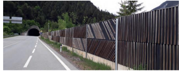
Abbildung 9: Lärmschutzwand NACH der Ertüchtigung (Holzbeton)
