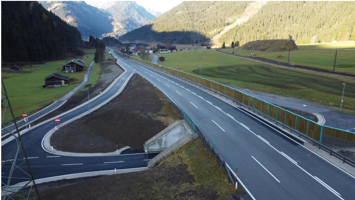
Abbildung 10: Fernpassstraße bei Lähn/Wengle, Umbaumaßnahmen samt Lärmschutzwand
