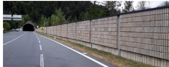
Abbildung 9: Lärmschutzwand NACH der Ertüchtigung (Holzbeton)
