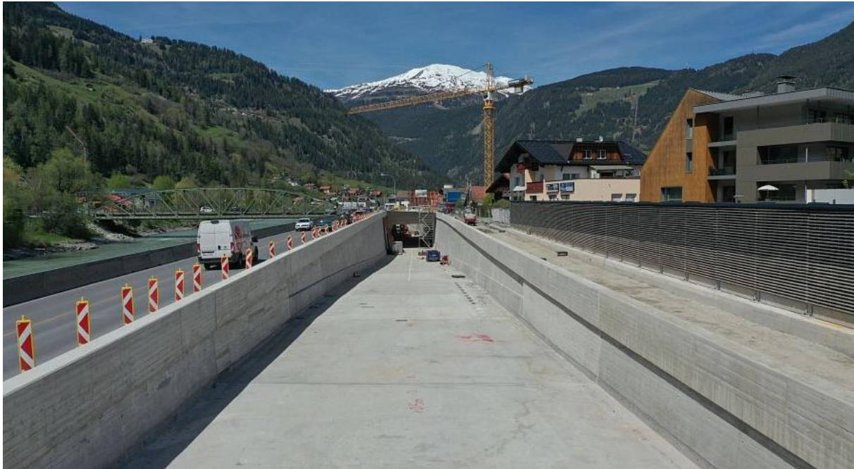
Abbildung 12: Unterführung der Reschenstraße in Prutz
