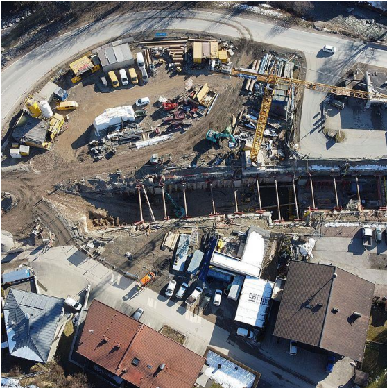
Abbildung 7: Baufortschritt der Unterflurtrasse der Loferer Straße
